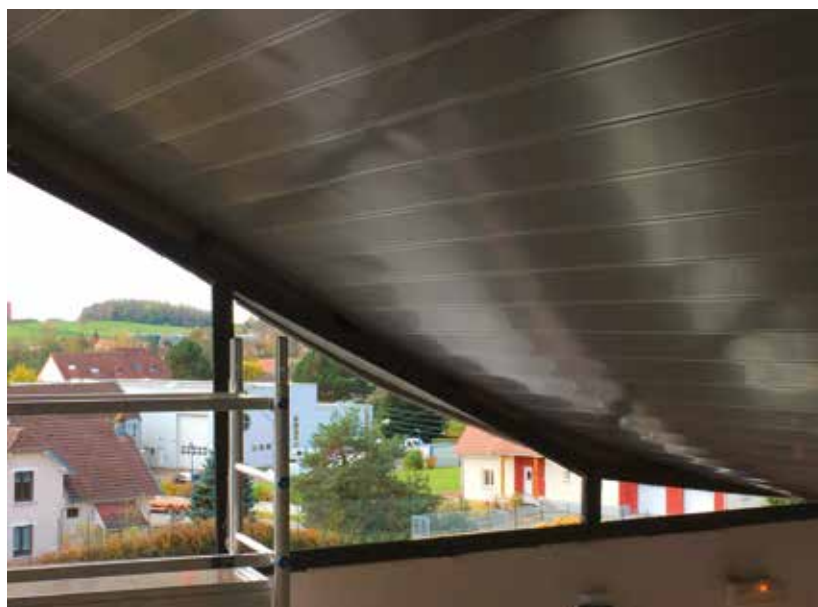
26 février 2021 : au Centre Culturel, les baies vitrées sont remplacées
