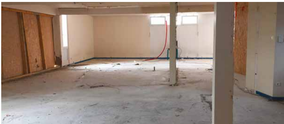
La nouvelle salle de classe voit le jour, entre espace et ensoleillement. Elle sera mise en service le 28 août 2021.
