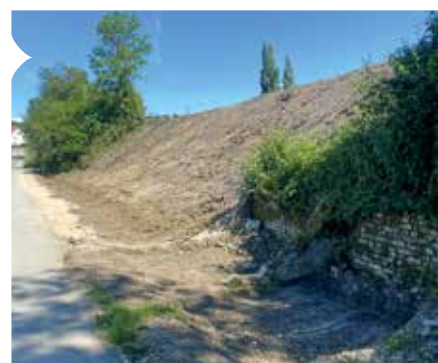
LE CHANTIER DE DÉPOLLUTION DE LA RUE DE L'USINE
