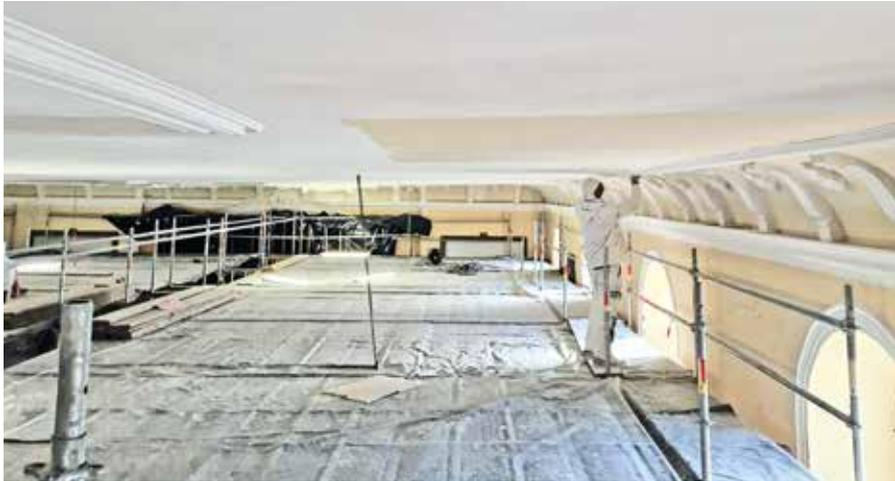
Le plancher provisoire permet de travailler sur le plafond en sécurité
